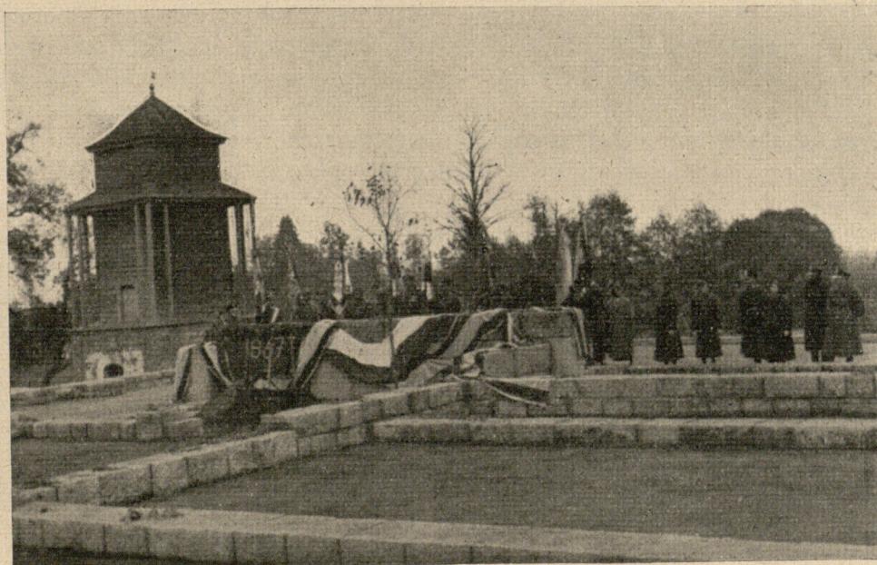
Żulów — zarys fundamentów — miejsce, w którym stała kolebka Marszałka.
