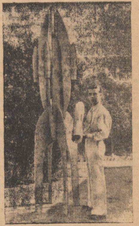
Rakieta stratosferyczna, konstrukcji amerykańskiego jublera. Do rakiety przytwierdzona jest część, zawierająca przyrządy pomiarowe. Na wysokości 200-u mil aparatura ta odłączy się od rakiety i wylądować może na spadochronie.
