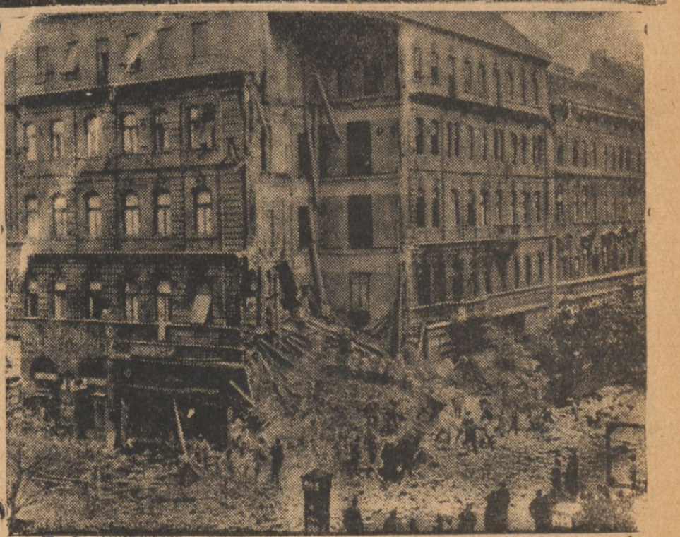
Katastrofalne zawalenie się domu w Budapeszcie. Około 40 oiar w ludziach.
