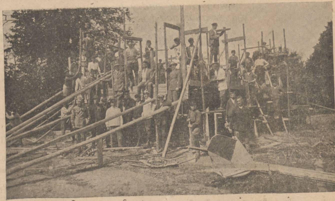
Uczniowie sejmikowej szkoły rolniczej w Bukiszkach przy budowie domu pokazowego glinobitnego.
