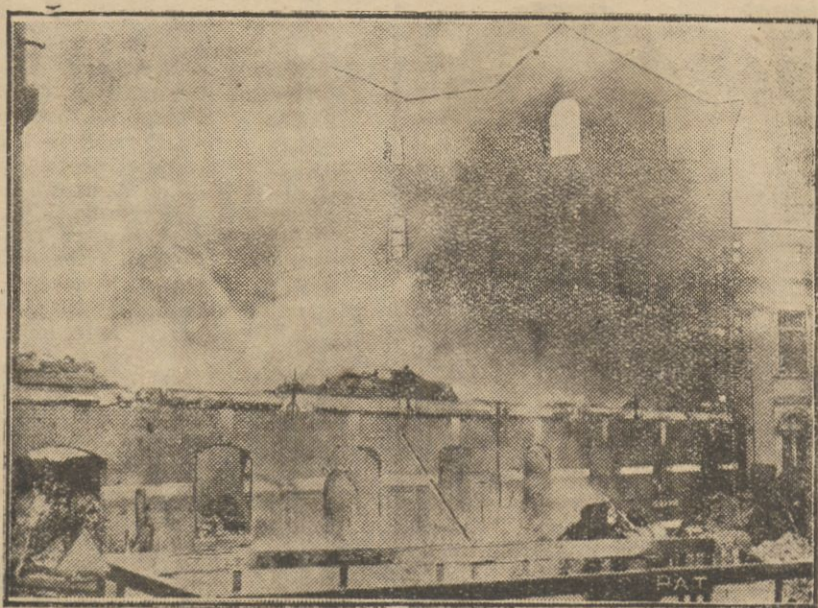
KATASTROFALNY POZAR W ANTWERPI W Antwerpi wybuchł wczoraj w samym śródmieściu, a mianowicie na rynku Św. Jakóba obryzki pożar, który zniszczył przytułek dla starców, gmach, w którym mieściły się różne organizacje i biura, oraz kilka domów prywatnych. Szkodę wyrządzoną przez pożar obliczają na kilkanaście milionów franków.
