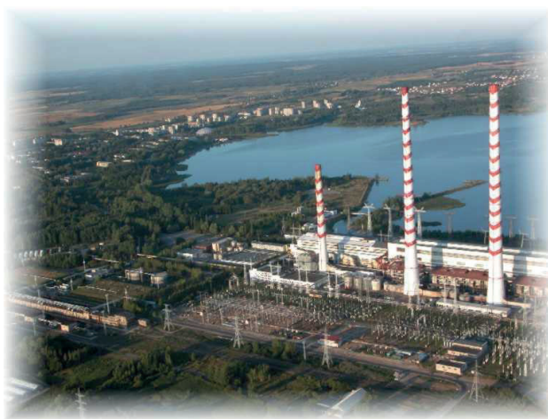
1.10 pav. Lietuvos elektrinė Elektrėnuose – didžiausia mūsų šalies šiluminė elektrinė. Ji degina mazutą ir dujas, kuriuose slypi kažkada augalų sugerta saulės energija.
