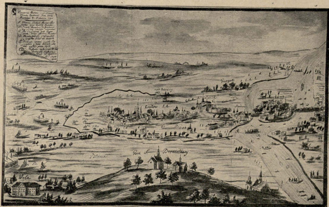
PRUSACY ZAJMUJĄ KRAKÓW
