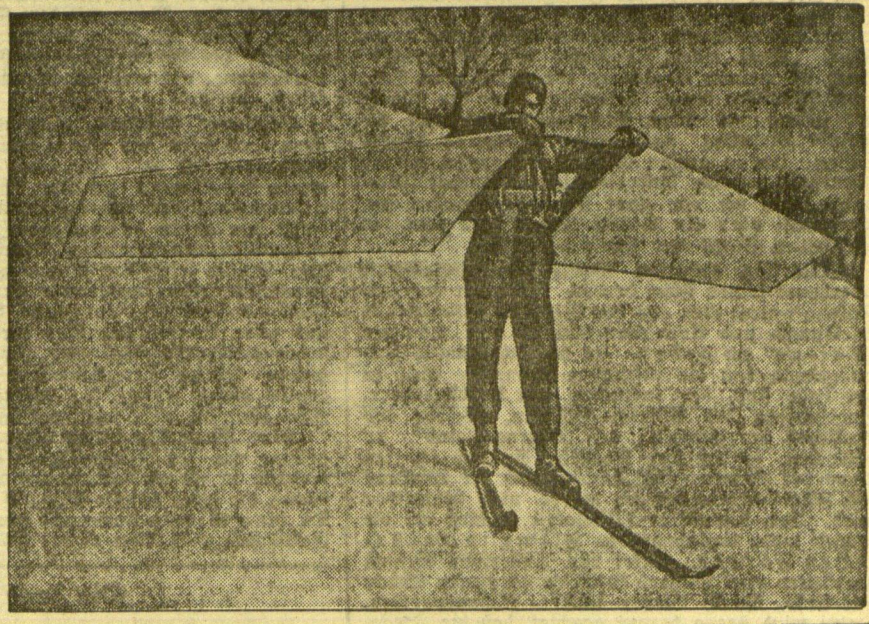
Der Eis-Segelkletter Die Konstruktion eines Wiener Erfinders, der sich ein Fingerringkonstrukt, mit dessen Hilfe er auch im Winter dem Segelflugport nachzugehen gedenkt. Die Fingerringe sind um ihre Achse drehbar und dienen so gleichzeitig als Höhensteuer.
