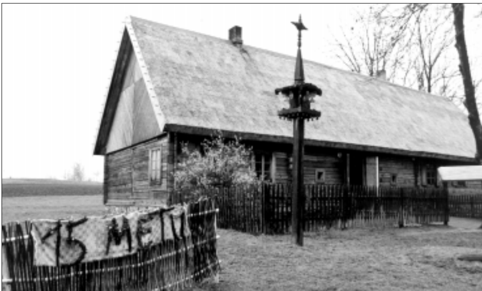
Atkurta daktaro Jono Basanavičiaus gimtoji sodyba Ožkabaliuose. Projekto autorė architektė restauratorė Živilė Mačionienė visuomeniniais pagrindais 1988 m. parengė visos sodybos atstatymo projektą.
