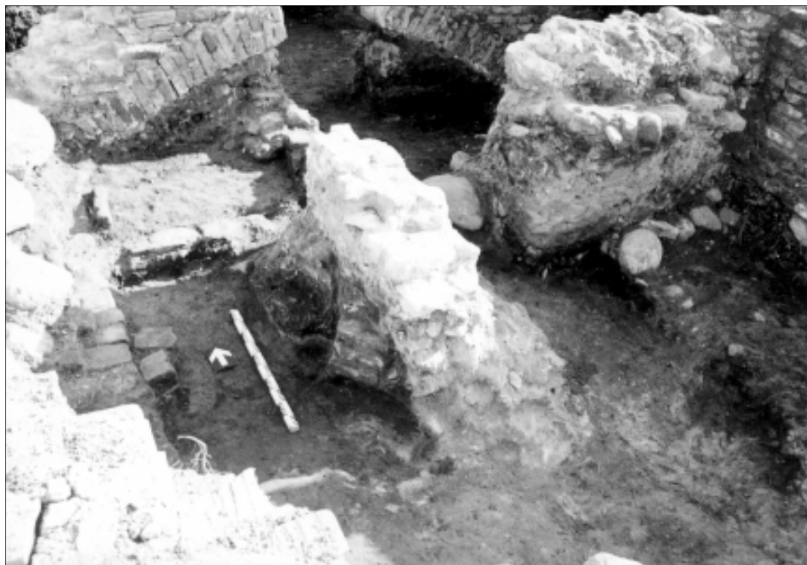
Sovietmečio statybų pėdsakai: išdaužyti arkiniai bei juostiniai pamatai
