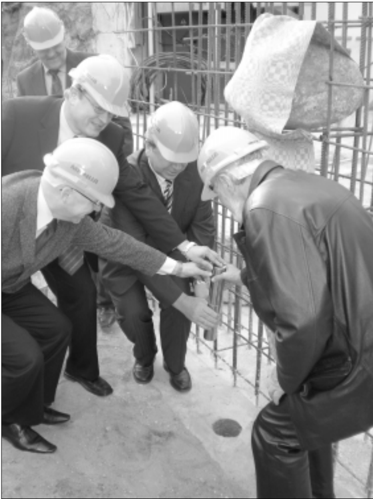
Kapsulė, kurioje fiksuojama Etnokosmologijos muziejaus rekonstrukcijos darbų pradžia, bus įmūryta į statinio pamatus
