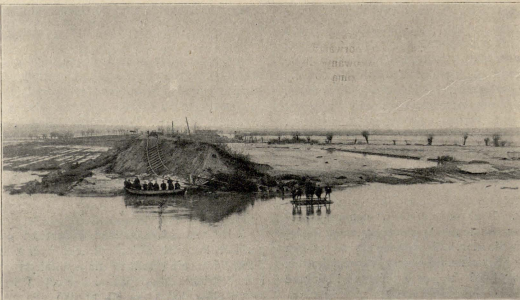
Wyrwa w planie kolejowym, po zniesionym moście, pomiędzy Sieciechowem a Garbatką.
