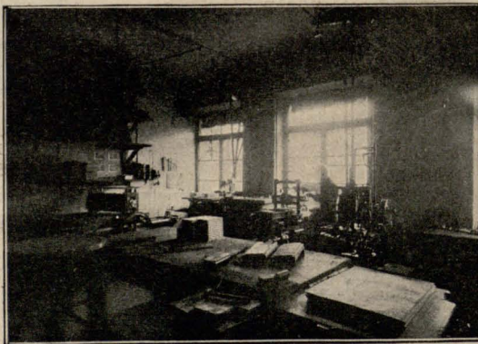
Hala maszyn pomocniczych.
