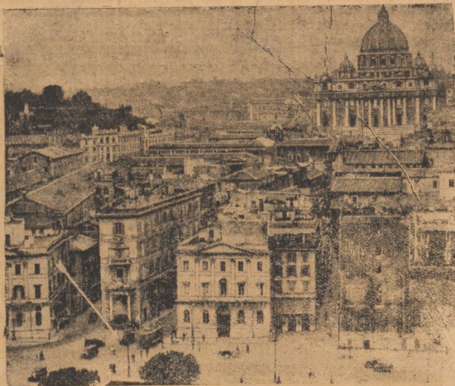
W dniu 28 bm. Benito Mussolini wyjmie jedną cegłę z Palazzo di Piazza, rozpoczynając w ten sposób burzenie całego bloku domów, na których miejscu powstanie ulica, prowadząca do kościoła św. Piotra.
