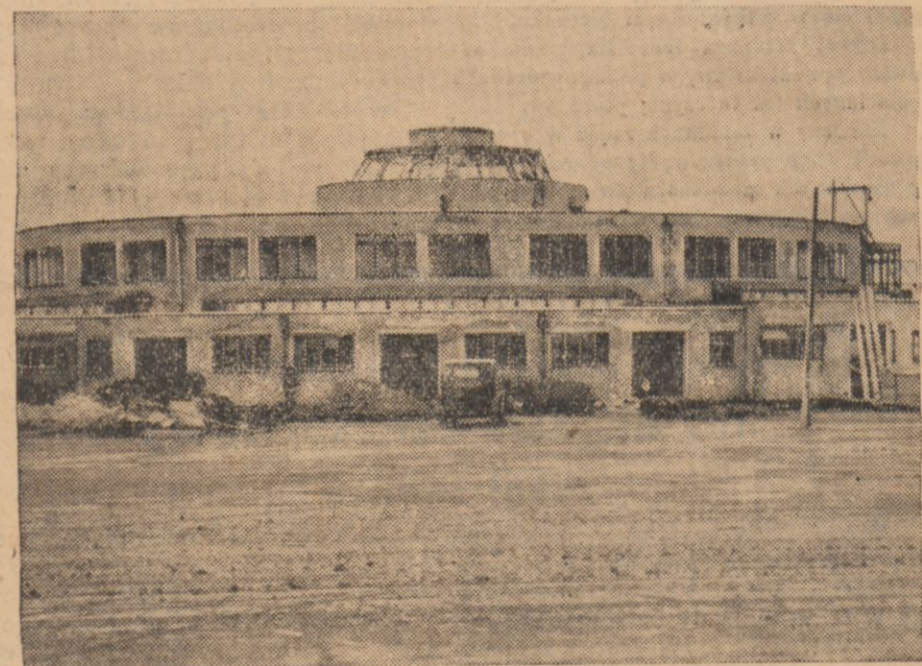
W Gatwick, pod Londynem, buduje się obecnie nowy port lotniczy, który jest już na ukończeniu. Na zdjęciu dworzec, zbudowany w kształcie okrąglaka.
