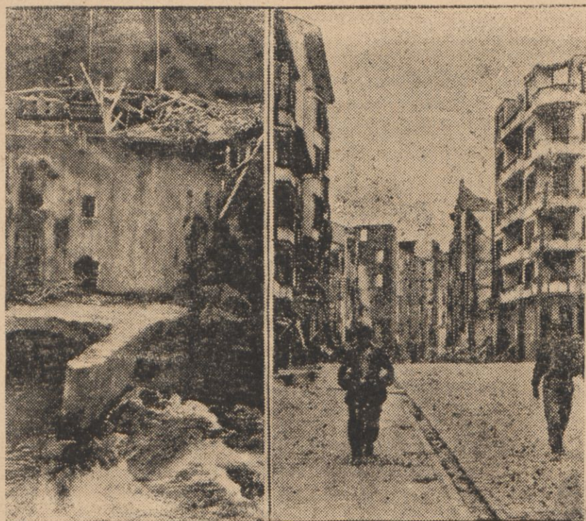
Z lewej strony wysadzony przez czerwonych most kolejowy. Z prawej — zrujnowane ulice w Eibar.
