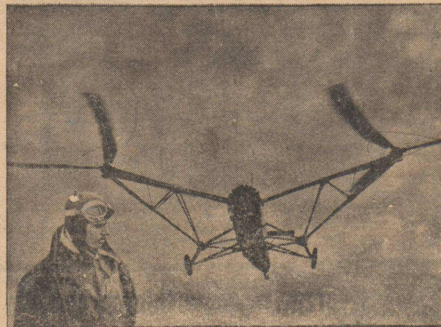
Lotnik Rohls pobił wszystkie międzynarodowe rekordy dla szybowców śrubowych na aparacie konstrukcji prof. Henryka Focke'a. Osiągnął na nim wysokość 2500 m., utrzymywał się w powietrzu przez 1 godz. 20 m. 49 sek., doszedł do szybkości 122,5 km. na godzinę. Przeleciał na nim 16,4 km. w prostej linii, a ogółem wraz z drogą powrotną odbył lot długości 80,6 km. Jest to pierwszy wypadek, w którym na aparacie tego typu dokonano większego przelotu.
