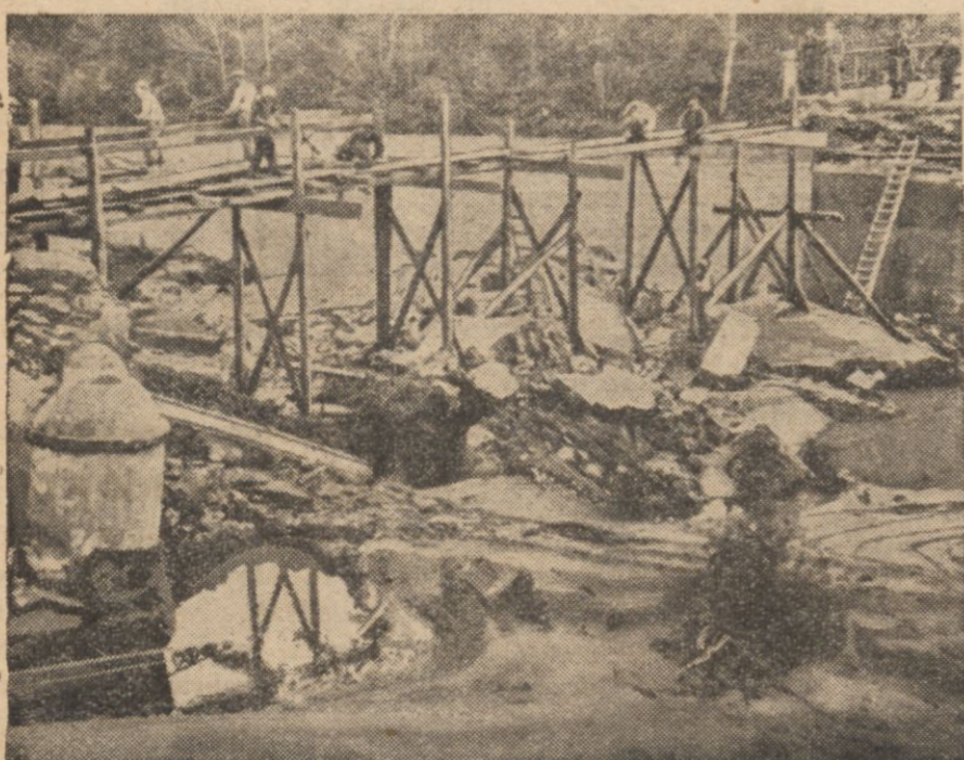
Most na rzece Bormida, zniszczony przez powódź.
