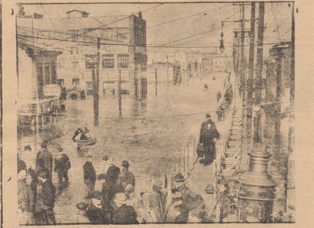
W Louisville w stanie Kentucky ruch pasażerski możliwy jest jedynie przy pomocy prowizorycznych drewnianych mostów — budowanych na wysokich palach.
