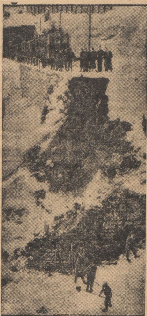
Między miejscowościami Brig i Kandersteeg w Szwajcarii, lawina śnieżna zniszczyła na znacznej długości most i nasyp kolejowy.
