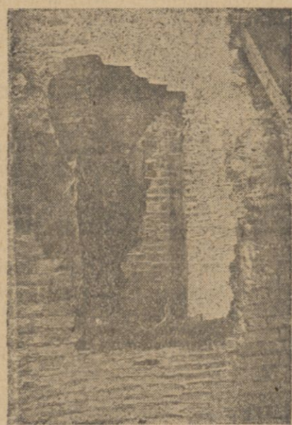
Odnalezienie przy pracach restauracyjnych schody w murze baszty.
