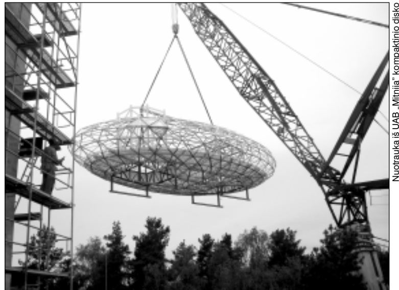
Atsakingiausias momentas: „skraidanti lėkštė“ keliami montuoti ant dviejų 40 m aukščio bokštų
