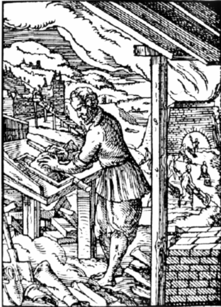
Viduramžių plytų gamyba Vokietijoje. Pirmajame plane – plytų gamintojas deda molio mišinį į medinę formą. Amanno Josto graviūra iš 1568 m. Hartmano Schoppero knygos „Panoplia“
