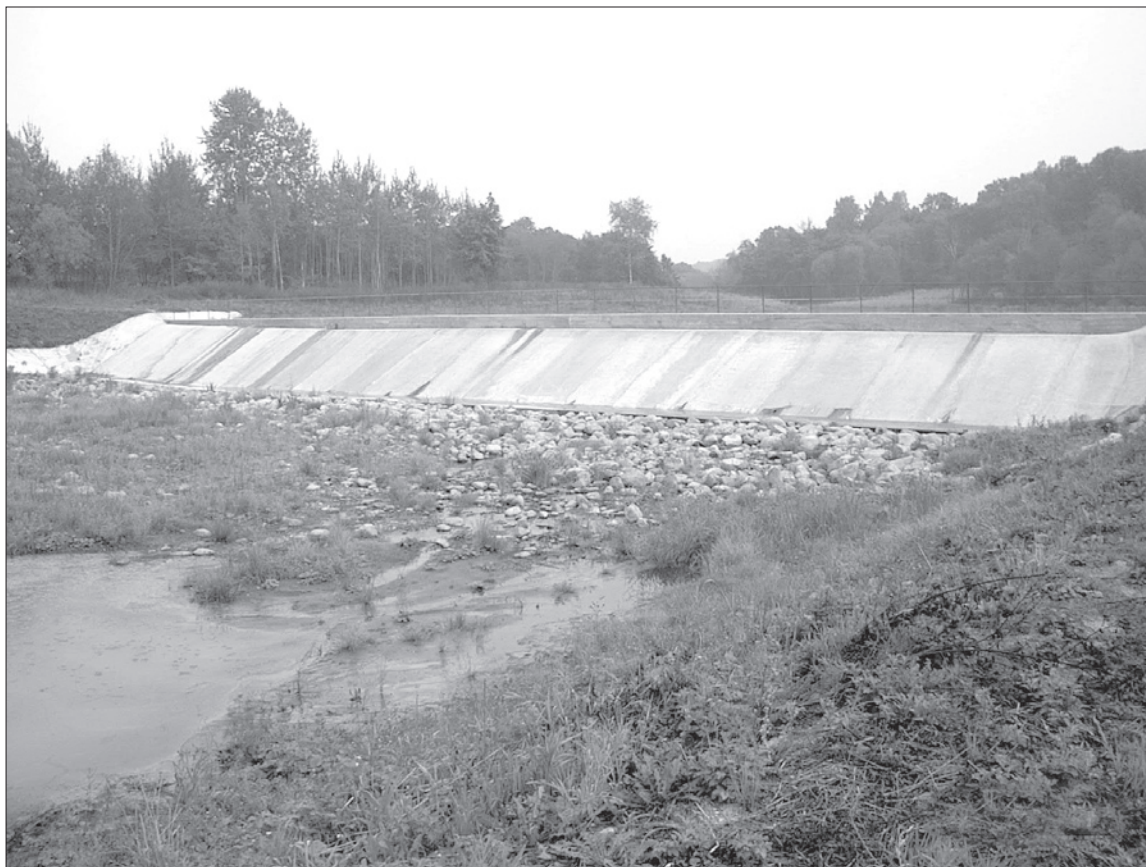
Štai kaip atrodo daugumos mažųjų hidroelektrinių (patvankos aukštis 4–6 m), kurios „nedaro“ neigiamo poveikio aplinkai, antroji, nefasadinė pusė. Valtūnų užtvanka ant Siesarties
