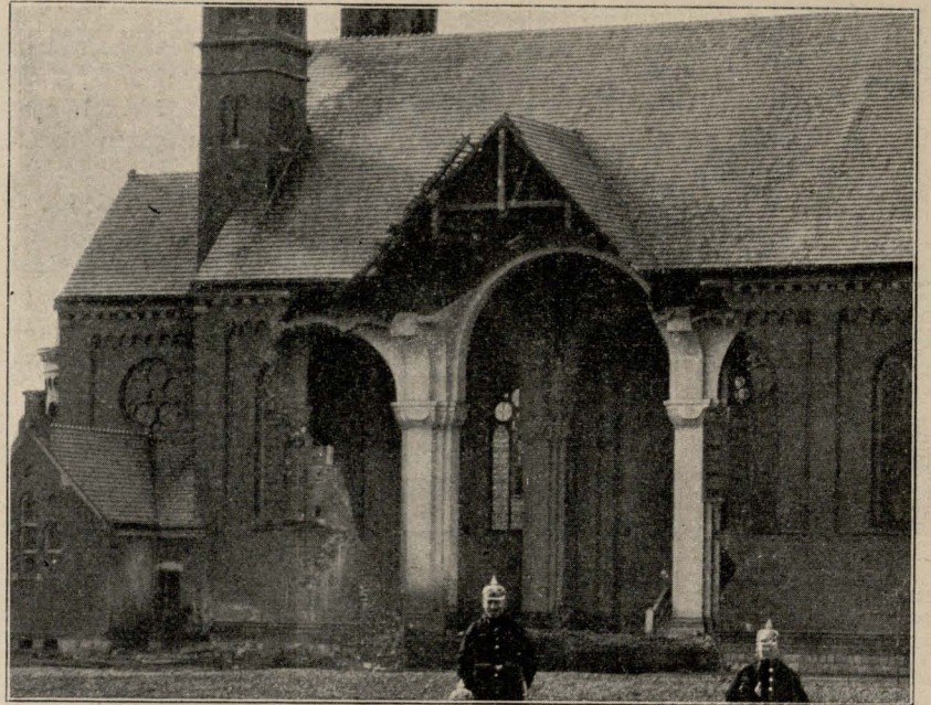
Kościół Matki Boskiej w Inowrocławiu. Zniszczona ściana kruchty z widocznymi filarami wewnątrz kościoła. Fot. I. Trando.
