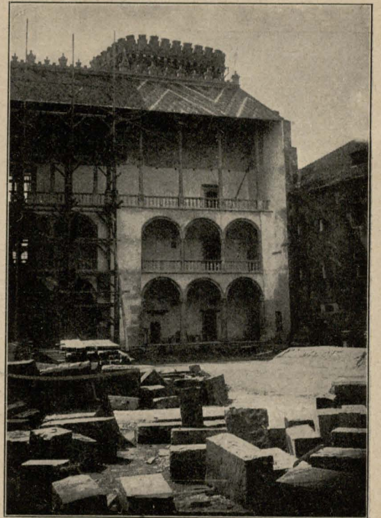
Odnowiona na próbę część skrzydła południowego. Dach pokryty wielobarwną dachówką, kolumny odślonięte.
