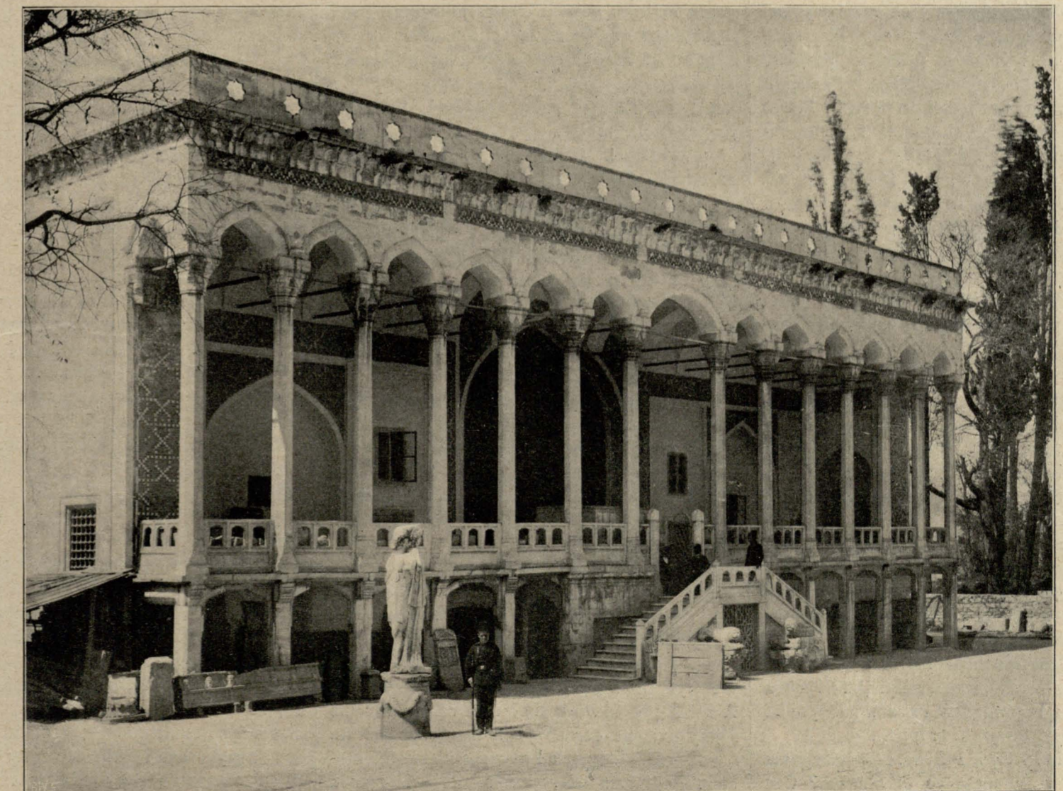
„STARY SERAJ”. FASADA PAŁACU CZIMLI-KIOSK.
