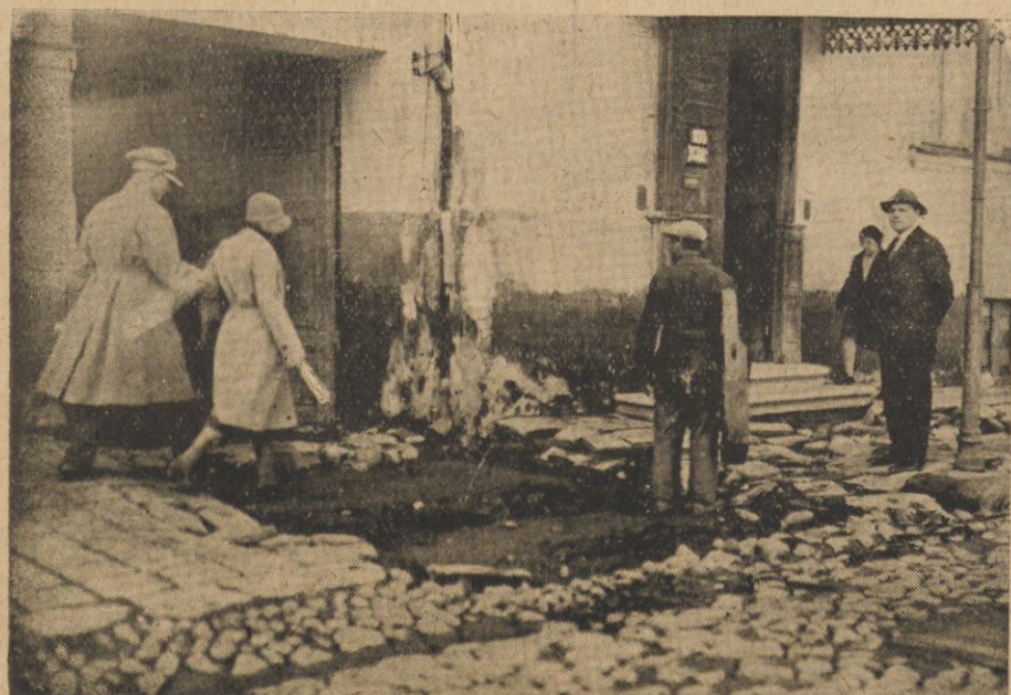
Gdy wody poczęły spadać. — Obraz zniszczenia na ul. Zyguntowskiej. Powyrywane płyty chodnika, uszkodzona jeźdnia i narożniki domów.
