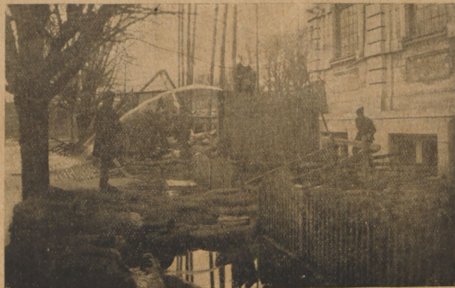
Wileńska straż ogniowa dniem i nocą wypompowywała wodę z Kółłowni Elektrowni.
