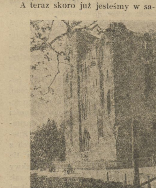
Na Dombergu — Ruiny, zniszczonej w w. XVI katedry i rezydencji biskupiej, w odnowionej swej części — będącej od kilkudziesięciu lat siedzibą Biblioteki Uniwersyteckiej.
