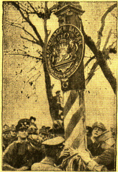
Die Grenzpfähle fielen
