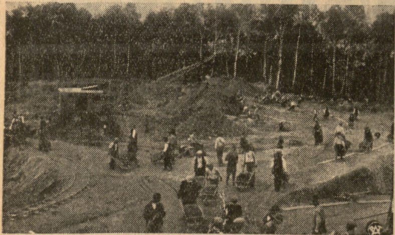
Prace przy budowie kopca na Sowińcu. Z nastaniem wiosny zostały wznowione i posuwają się w szybkim tempie prace około budowy Kopca Marszałka Józefa Piłsudskiego na Sowińcu pod Krakowem. Całe rzesze robotników przy pomocy dźwigów mechanicznych przenoszą ziemię do Kopca. W ten sposób maszyn Kopca coraz bardziej potężnieje. Na zdjęciu fragment robót ziemnych przy Kopcu.
