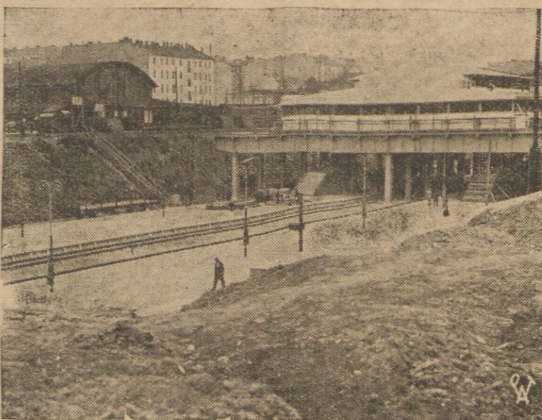
Widok na nowy tymczasowy dworzec średnicowy w Warszawie, po zburzeniu okalającego go w Alei Jeruzolimskiej. Widoczne są podjazdy po obu stronach odkrytego tunelu, oraz perony betonowe, na których ustawiono już zewnętrzne, wysokie latarnie elektryczne. Tory na tem miejscu są całkowicie wykończone.
