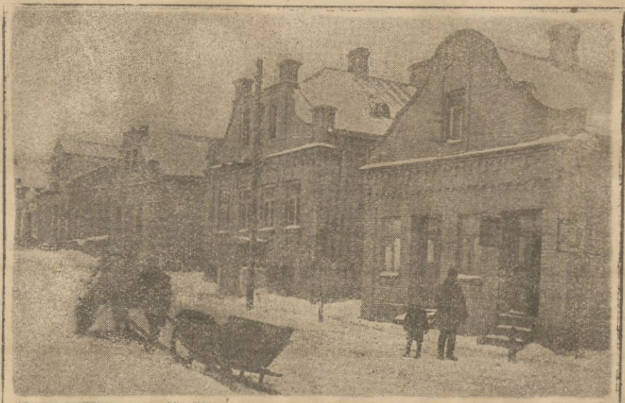
Zamiast drewnianych — murowane.
