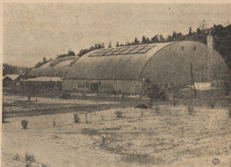
W Sztokholmie w tych dniach ukończono budowę największej na świecie hali tenisowej. Dziś nastąpi jej poświęcenie i oddanie do użytku publicznego. W tym dniu odbędą się w niej rozgrywki finałowe o puchar króla Szwecji między drużynami francuską i szwedzką. Na zdjęciu budynek nowej hali.
