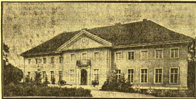
Auf Schloß Neudeck, dem ostpreussischen Herrenhof der Hindenburgs, ist es in diesen Tagen, wie bereits gemeldet, zu einem Dachstuhlbrand gekommen, der jedoch glücklicherweise rechtzeitig erlosch und rasch gelöscht werden konnte.
