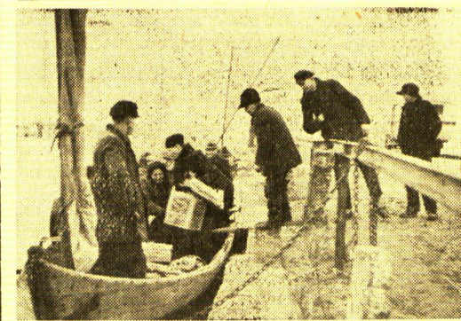
Auf der Chaussee Heydekrug—Ruß Oben: Ein Wagen fährt die überschwemmte Chaussee entlang. Unten: Die Passagiere des Omnibusses müssen die überschwemmte Teilstrecke in Kähnen zurücklegen.
