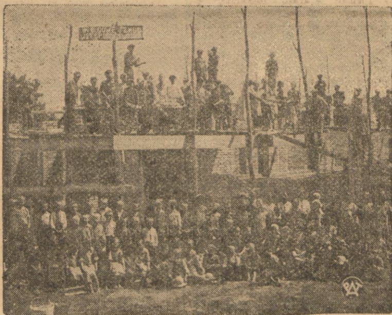
70-cio dzieci ze wsi Mykiłcz, pow. dubieńskiego na Wołyniu, które z powodu braku budynku szkolnego nie mogą uczęszczać do szkoły, pomagają własnoręcznie przy budowie swej przyszłej szkoły.
