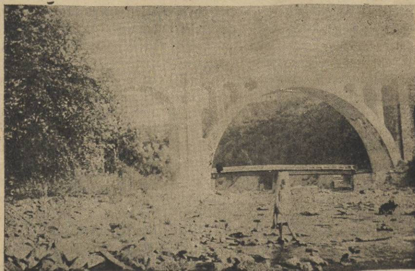
Wiadukt nad Prutem.
