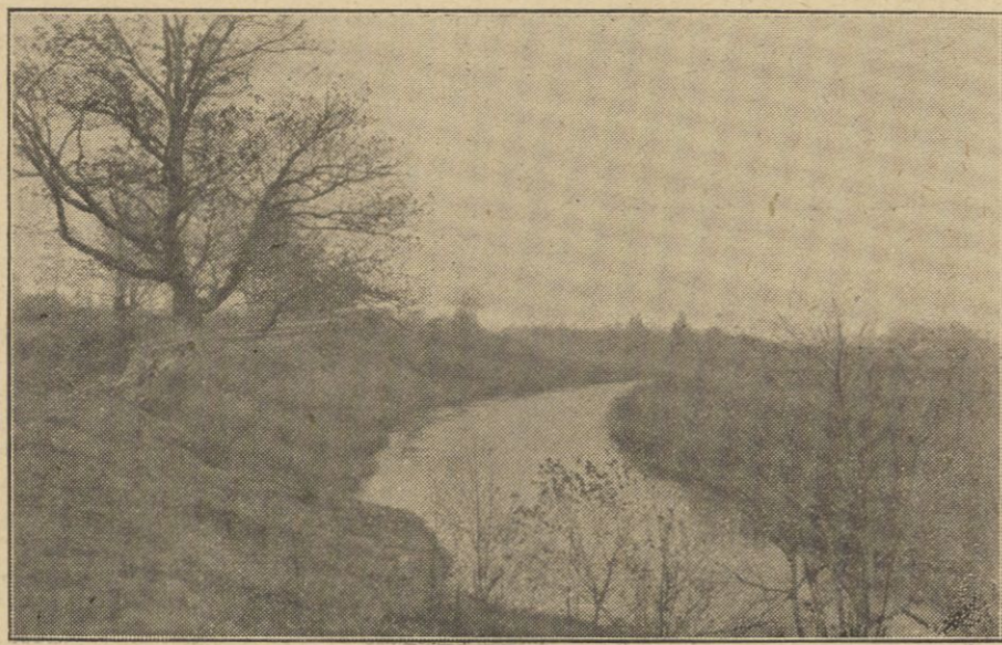
Rzeka Dźwienka obok majątku Staniszcze, przez którą rzucony będzie most kolejowy.
