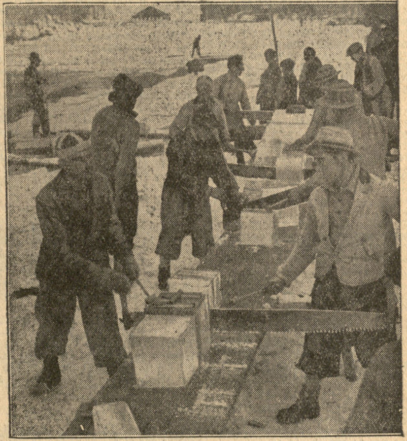
Budowa toru saneczkowego w Garmisch-Partenkirchen na zawody olimpijskie jest niemal na ukończeniu. Obecnie wykrawa się z pobliskiego jeziora wielkie bloki lodu, piluje się je na bloczki kwadratowe (zdjęcie na prawo) i wyklada się nimi zakręty toru, aby zapobiec wywracaniu się sanek podczas zawodów.
