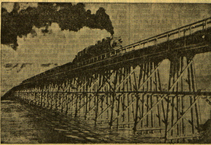
Vom Bau des größten Staubdammes der Welt
