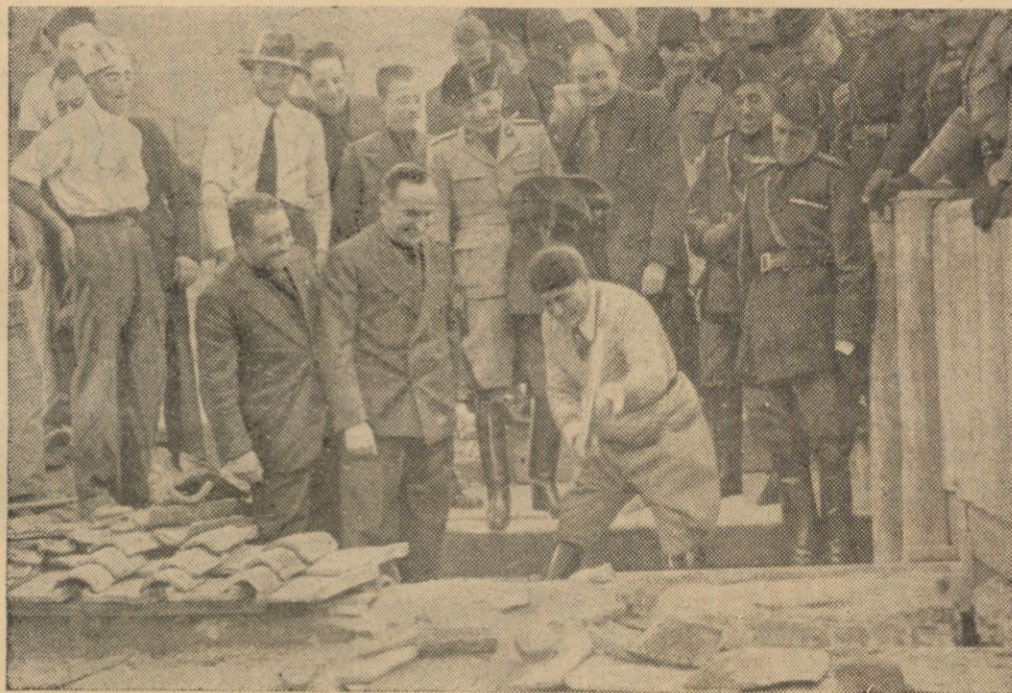
Ostatnio dekonał Mussolini inauguracji wielkich prac urbanistycznych w Rzymie, mających na celu regulację dzielnicy, gdzie się znajduje mauzoleum imperatora Augusta Octawiana. Na ilustracji — Mussolini z kilofem w ręku rozpoczyna roboty.
