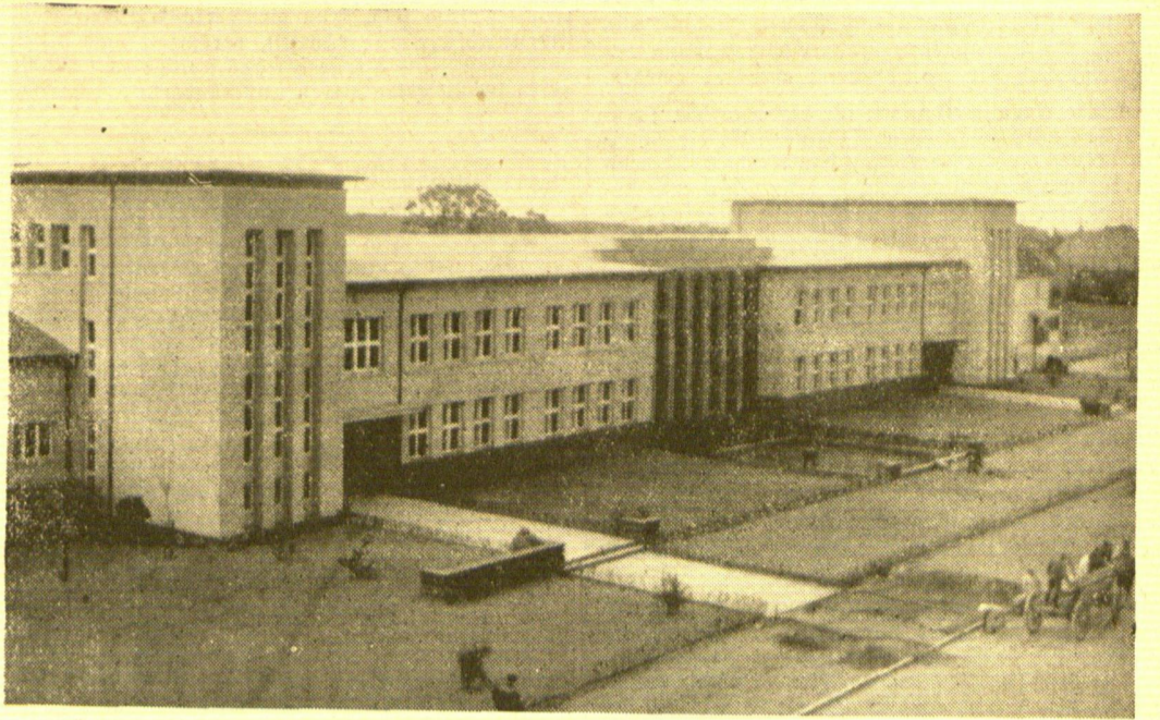
In der Kant-Strasse ist der Bauzaun gefallen
