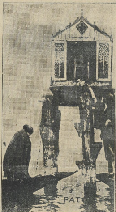
Rybacka kapliczka na morzu, ustawiona na wbitych w dno grubych palach.
