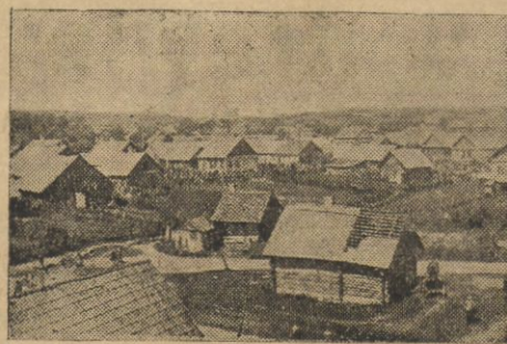
Widok z połudn. wieży na Krewo.
