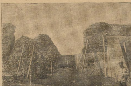
Ściana południowa zamku krewskiego
