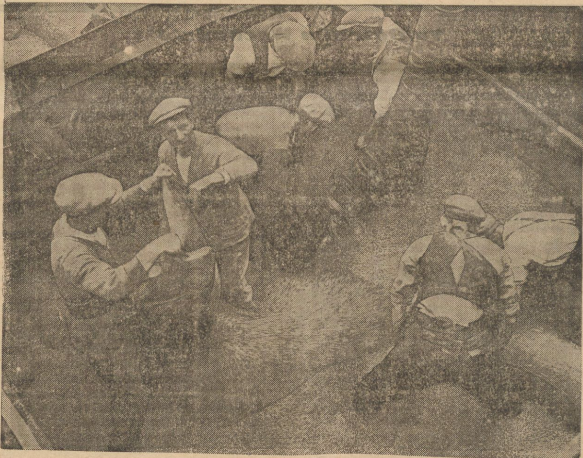
Nie, to nie woda, to... zboże. Tak, autentyczne zboże, które statek brytyjski przywiózł z Australii i w tej chwili, stojąc na Tamizie „wyladowuje” za pomocą pompy na brzeg. W zbożu widzimy zanurzoną rurę ssącą towar ze zbiornika okrętowego
