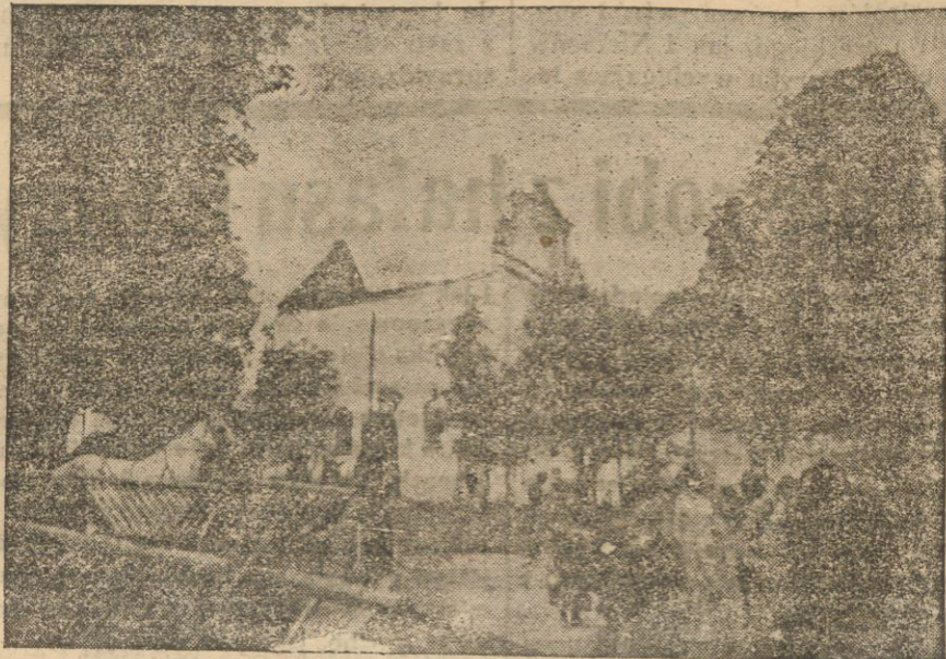
Widok kościoła zabytkowego w Szczepieszynie z zerwanym dachem.
