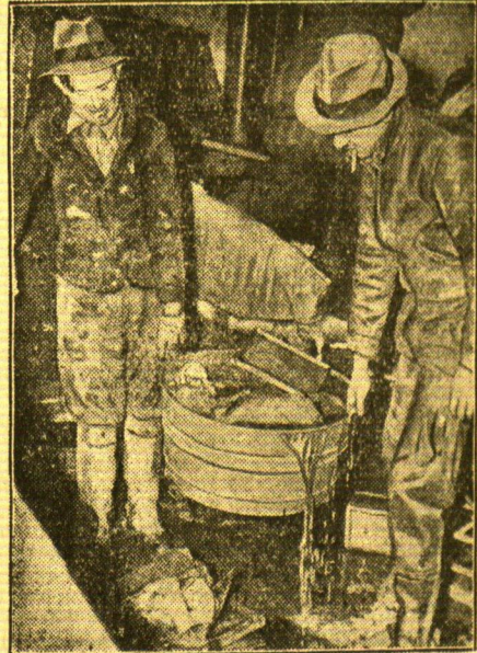
Endlich zieht sich die Flut zurück. Nach dem Rückgang des Hochwassers des Obis lassen sich die Schäden der Katastrophe übersehen. Die Bevölkerung kehrt ihre Wohnungen kaum wieder; überall haben sich Schlamm und Schutt eingenistet. Diese Aufnahme wurde in dem zweiten Stock eines Hauses von Portsmouth gemacht
