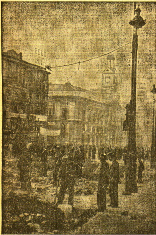
Vom Kampf um Madrid Mit verzweifelten Anstrengungen bemühen sich die Roten in Madrid, die Stadt in einen verteidigungsfähigen Zustand zu versetzen. Unser Bild zeigt sie beim Ausheben von Schützengraben in der Nähe von Puerta del Sol (Sonnentor) in Madrid.
