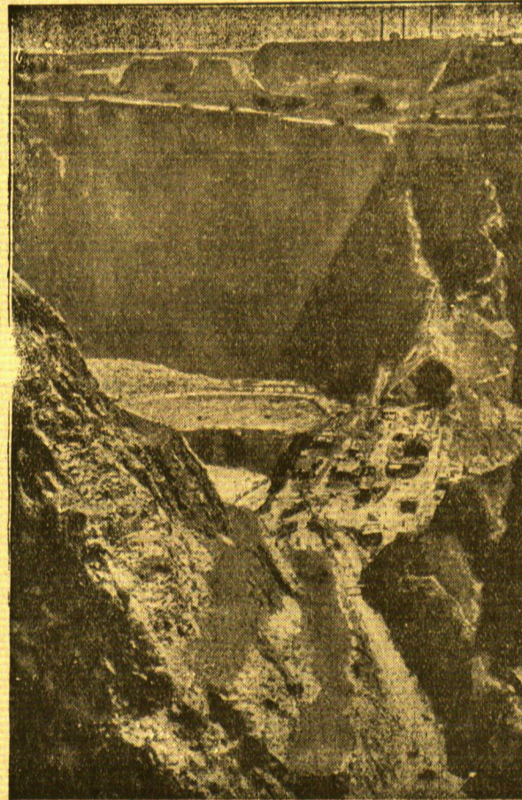
Blick in die Tiefe einer großen Diamantenmine in Südafrika
