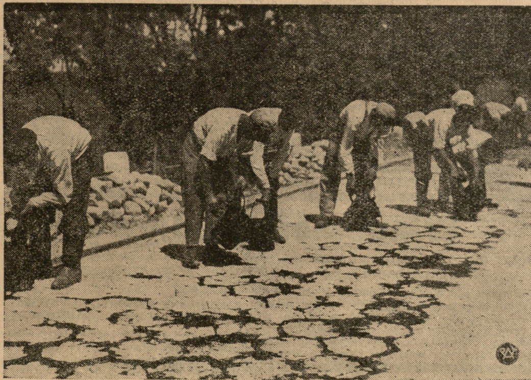
Zdjęcie nasze przedstawia budowę szosy pod Zegrzem (woj. warsz.) z kostek betonowych.
